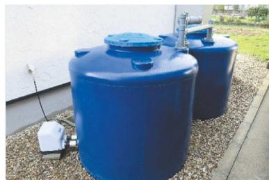
図2. 戸建て住宅用自動制御雨水活用システム
