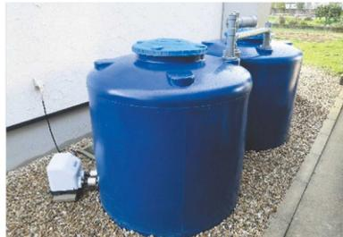
図2. 戸建て住宅用自動制御雨水活用システム
