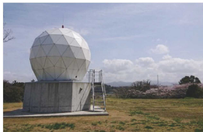
図1.口径3.9mパラボラアンテナシステム
