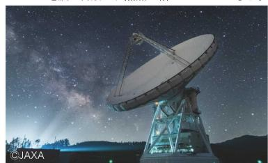
図3 2021年に完成した、JAXA臼田宇宙空間観測所美笠深宇宙地上局の54mパラボラアンテナ。
