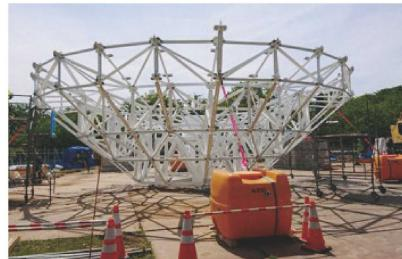
図2.口径13.5mアンテナシステム（建設中）
