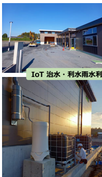
トータル雨水利用システム (ファーストウッド：2400L 福井市)
