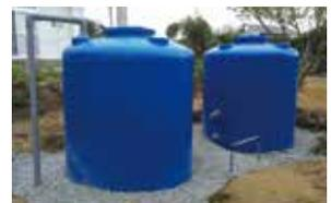
図3 大型雨水貯留槽(3m<sup>3</sup>×2基)
