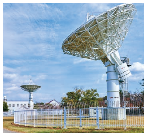
〈Fig.2〉 Aperture 13.5m parabolic antenna system
