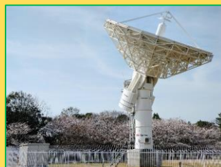
口径13.5mパラボラアンテナ
