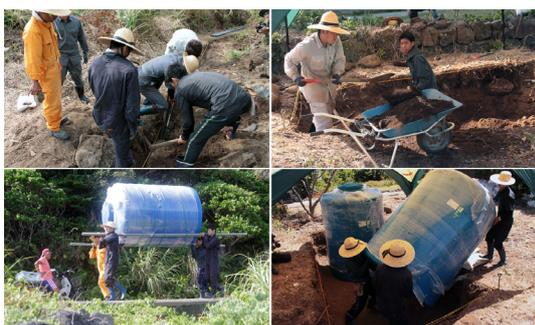
図 雨水タンク設置、配管作業 (2018 年)
