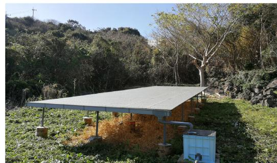
図 赤島に設置した雨水集水面「雨畑」2017/8
