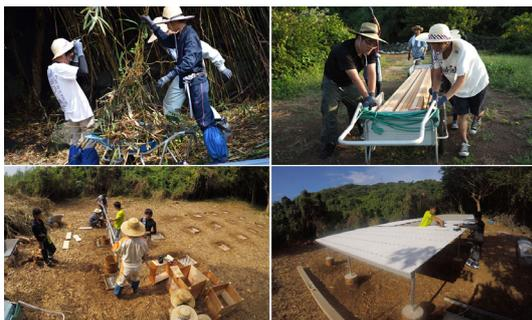
図 雨水集水面の設置作業
