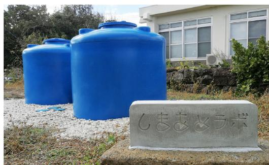
図 赤島に設置した大型雨水タンク (3m<sup>3</sup>×2)
