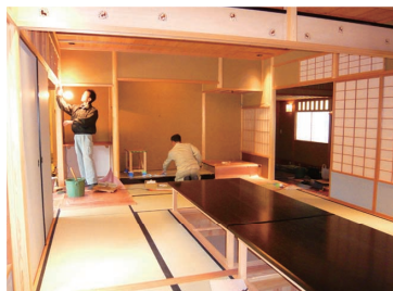
完成間近の茶室工事現場（設計活動）
