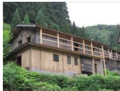
小原 ECO プロジェクトによる古民家修復の事例
