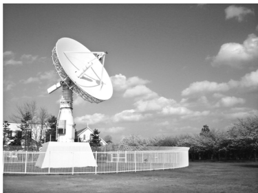
直径10メートルのパラポラアンテナ／あわらキャンパス
