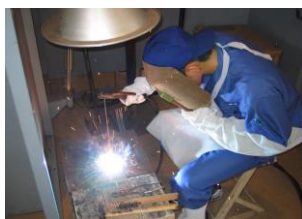
アーク・ガス溶接の作業
